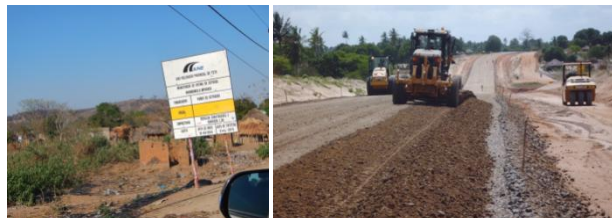
Figura 57 – Trabalhos de Conservação Troço Nhamdando –Mphende (R601) e Mphende - Mukumbura (R602)
