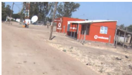
Figura 46 – Antena de Comunicações
